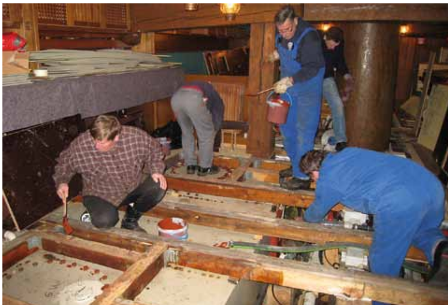
Die Crew beim Konservieren der Tanks im Großraum
