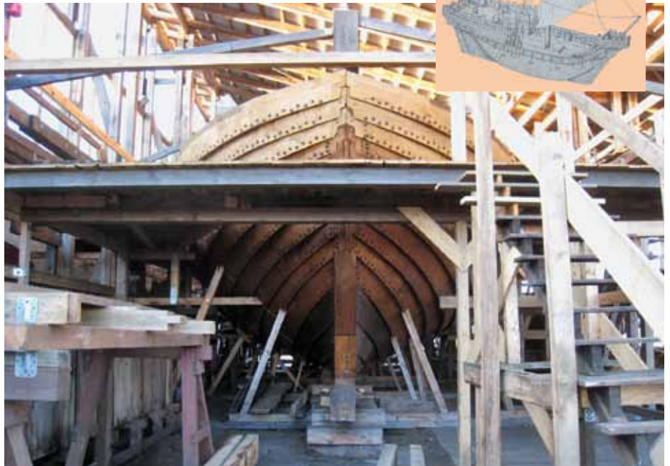
Der derzeitige Bauzustand der Uecker-Randow-Kogge
